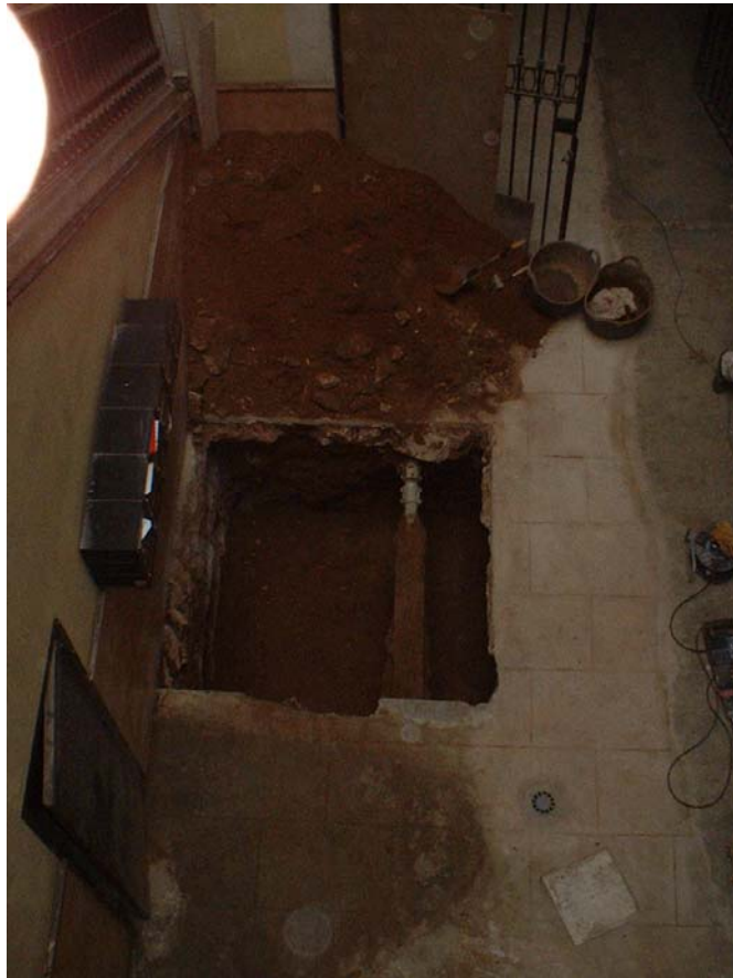
Fotografia 5: Vista general de la cala una vegada finalitzats els treballs del seu buidatge, on s'aprecia la canonada d'aigua.
